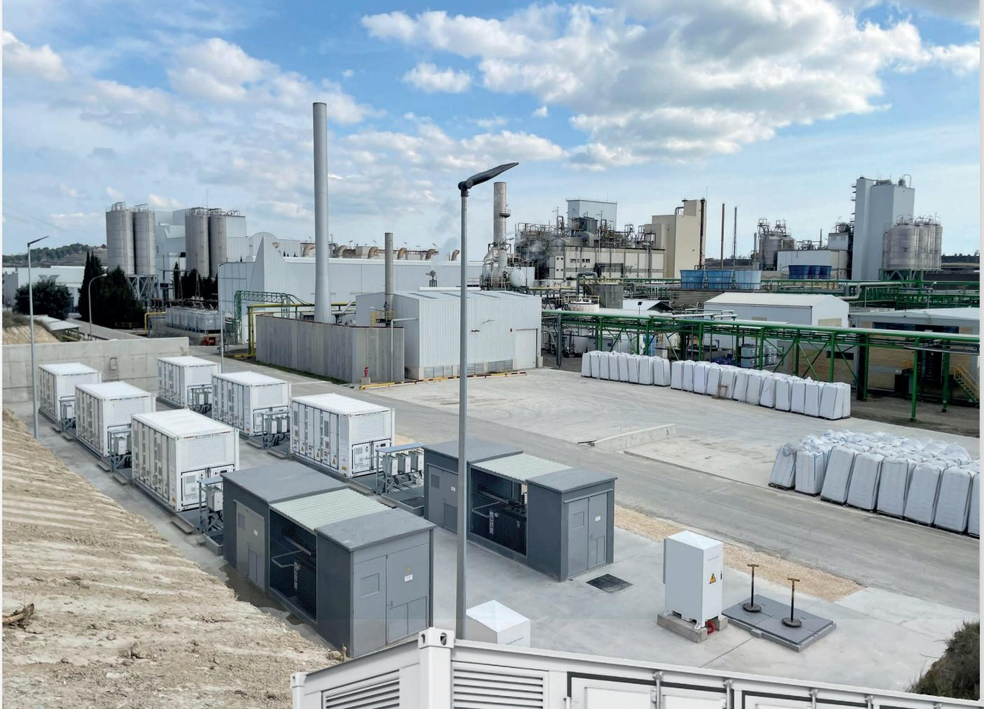
*Imagen de uno de los complejos industriales de Barbastro donde se aprecian los contenedores BESS, los PCS y los Centros de Transformación necesarios para elevar la salida de los PCS (800Vac) a Media Tensión y así conectarse a la infraestructura eléctrica de la instalación. En la segunda foto detalle de contenedor BESS de 2MWh*
