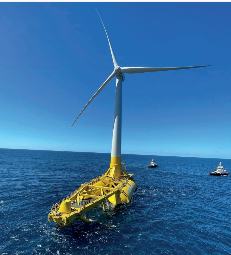
Saitec ha colocado frente a la costa de Vizcaya una máquina de dos megas sobre su prototipo de plataforma flotante DemoSATH
