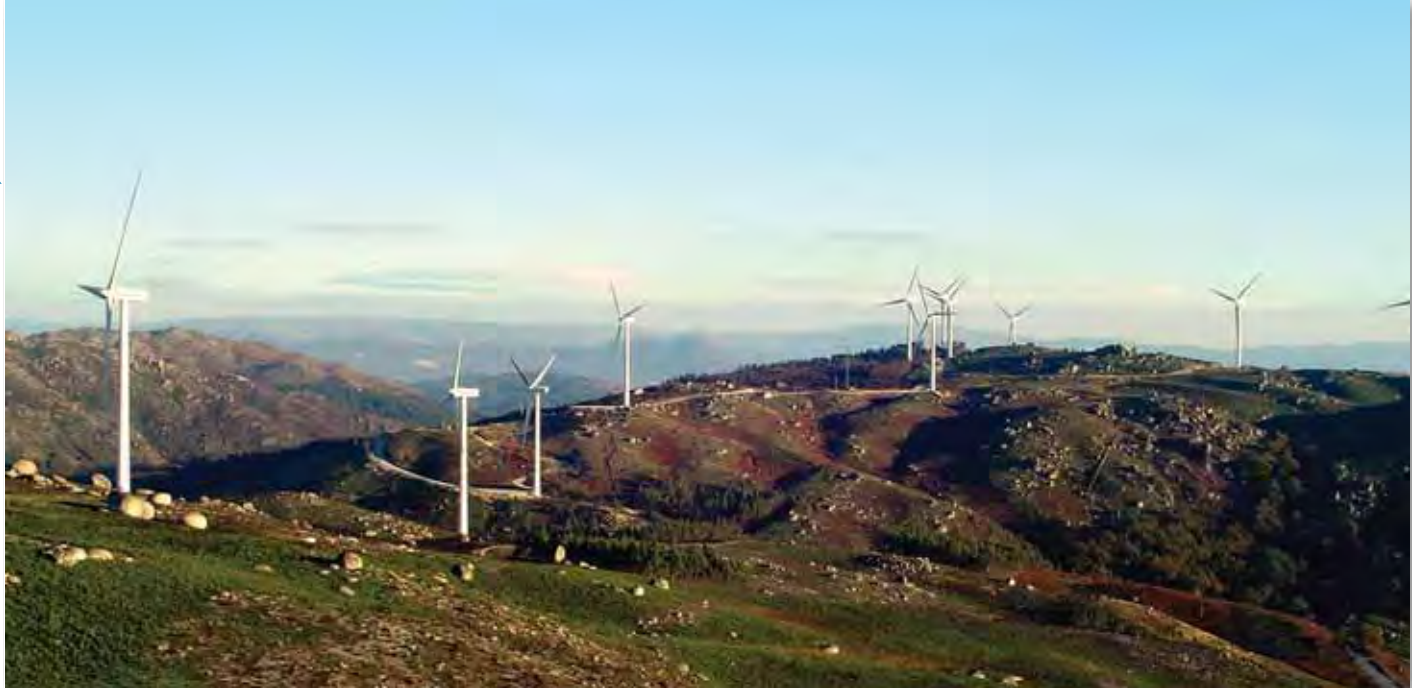
Parque eólico de Gamesa en Terras Altas de Fafe, Portugal.
