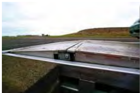
Cada vez que un eje del vehículo pasa por encima de las bandas se ponen en marcha una serie de engranajes que, conectados con un generador, producen energía eléctrica.
