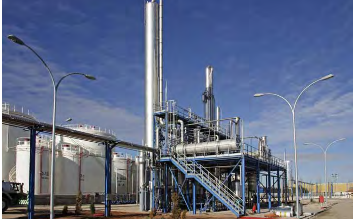
Planta de bioetanol de La Mancha, de Acciona.
