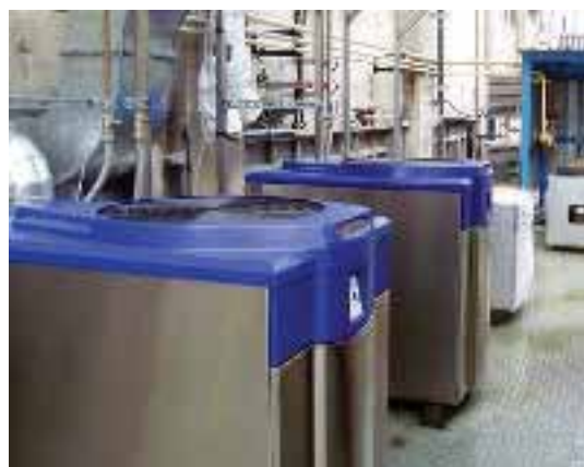
De entre todas las experiencias en campo que se han realizado hasta el momento en toda España, destaca la realizada por iniciativa del IDAE en la planta de Rotartica en Basauri (Vizcaya), para la climatización (frío y calor) de oficinas, salas de reuniones y laboratorios de Rotartica, S.A.
