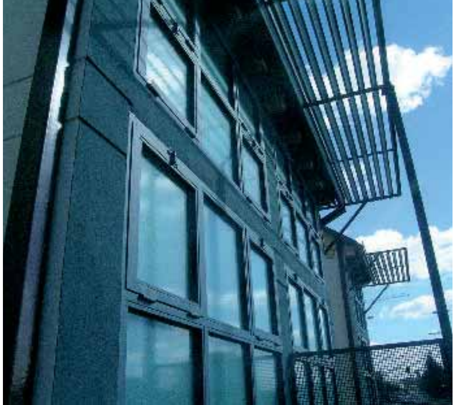
Arriba, viviendas en Valladolid, proyectadas por María Jesús González Díaz, que contienen muchos de los principales aspectos que deben estar presentes en un ejercicio completo de edificación sostenible: arquitectura bioclimática, utilización de materiales lo más naturales y lo menos contaminantes posibles, uso de las energías renovables ...
