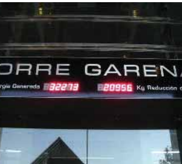
Abajo, Torre Garena. Inaugurado el pasado año en Alcalá de Henares (Madrid), el edificio forma parte de un complejo empresarial y de ocio, Garena Plaza.
