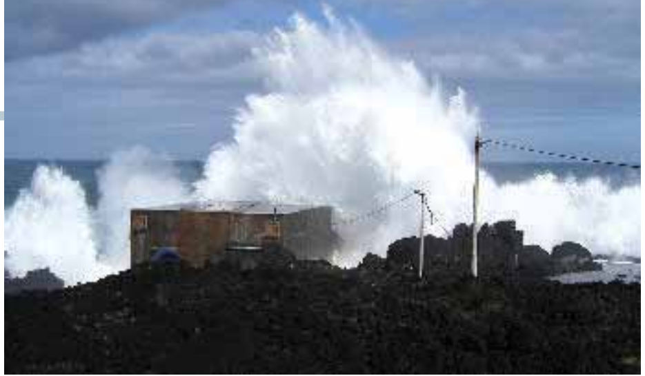
En la isla de Pico (Azores) opera un prototipo de central que emplea el sistema de columna de agua oscilante.
