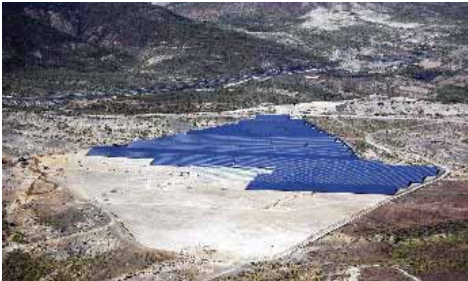
El archipiélago canario, concretamente la isla de Tenerife, albergará en breve una de las mayores instalaciones de energía solar fotovoltaica del mundo conectada a red.
