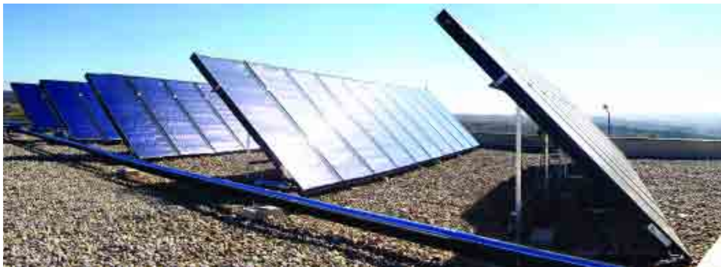
Arriba, instalación de Enerpal en el polideportivo La Legua (Toledo) para ACS y climatización de la piscina. La foto de la izquierda es del complejo acuático Getafe Norte, cuyo sistema solar ha sido instalado por la empresa Aurasolar.
