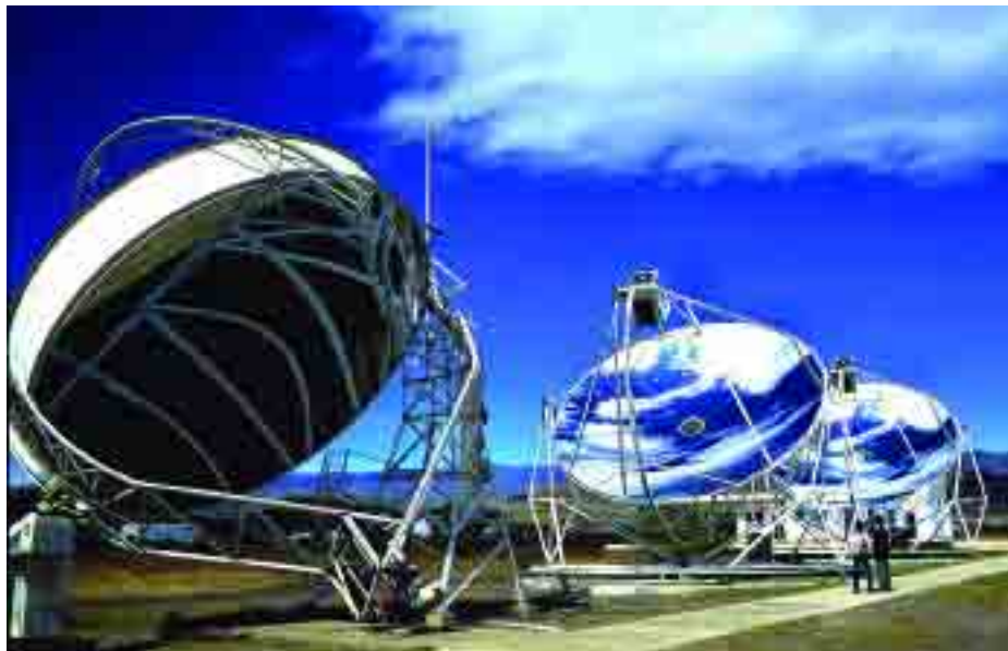
Tres discos parabólicos instalados en la Plataforma Solar de Almería, gestionada por el CIEMAT. En sus instalaciones se investiga con todas las tecnologías relacionadas con la energía solar.
