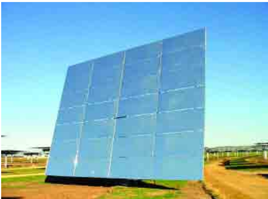
Dos imágenes de la PS 10, la central de torre de 11 MW de potencia que construye Abengoa-Solúcar en la localidad sevillana de Sanlúcar la Mayor. Es la primera planta comercial de este tipo en el mundo, aunque pronto vendrán otras similares.
