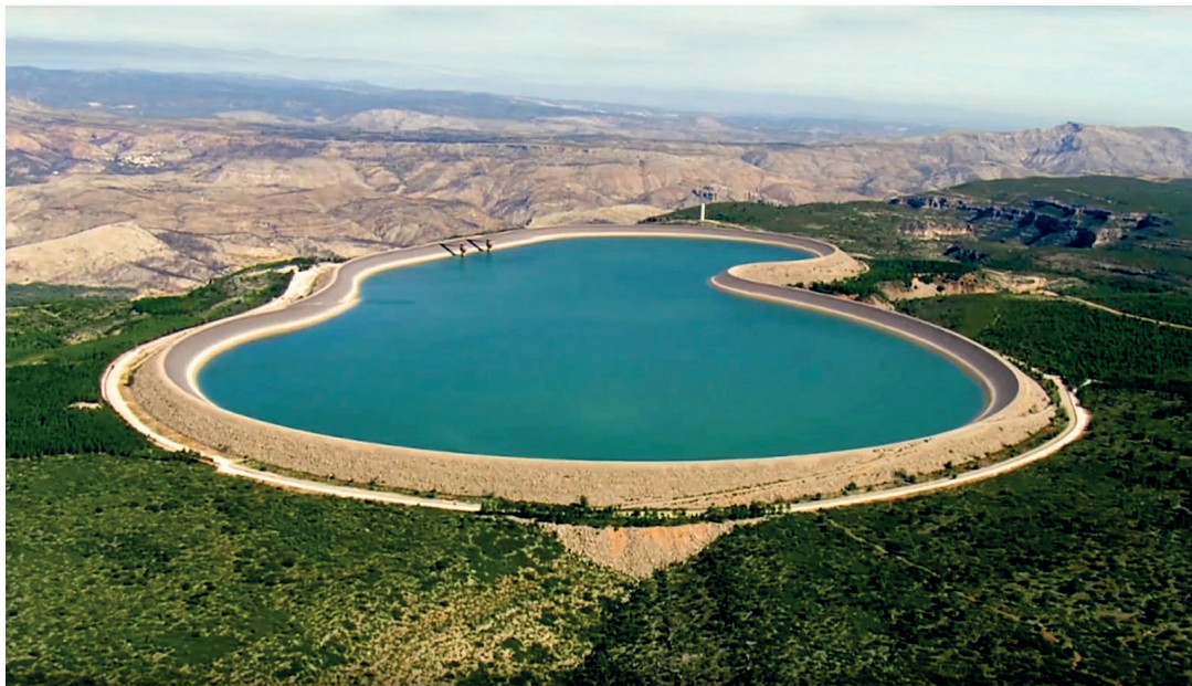
Central de bombeo de La Muela, de Iberdrola
