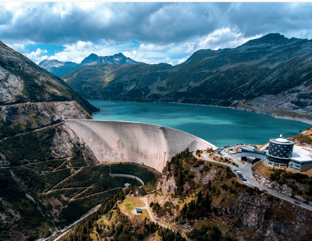
Foto: EITP hydropower
