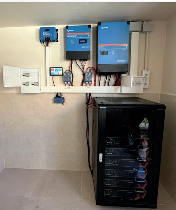
*Dos instalaciones de baterías en sistemas de autoconsumo de las empresas Solarix (izquierda) y Cambio Energético (derecha), ambas con sistemas Victron y baterías Pylontech y ByD*
